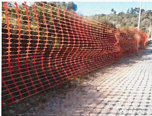
Exemples de dispositifs de mise en défens temporaire des emprise chantier
